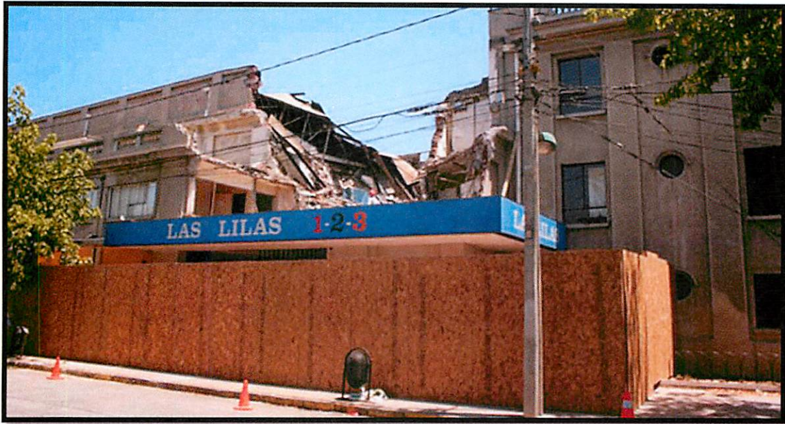
Figura 15. Fotografía Demolición Cine Las Lilas.
